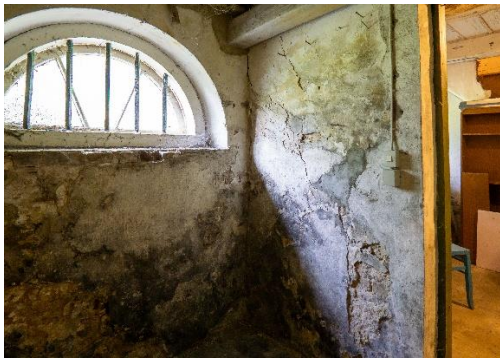
Abbildung 5/6: Risse, Feuchteschäden und Stützen im Keller
