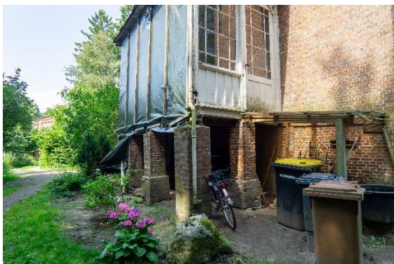
Abbildung 7/8: Notgesicherte Veranda
